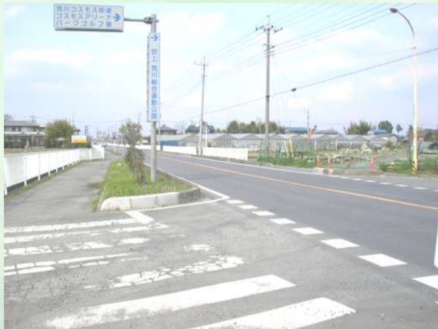
写9 行田東松山線(大芦交差点整備)
