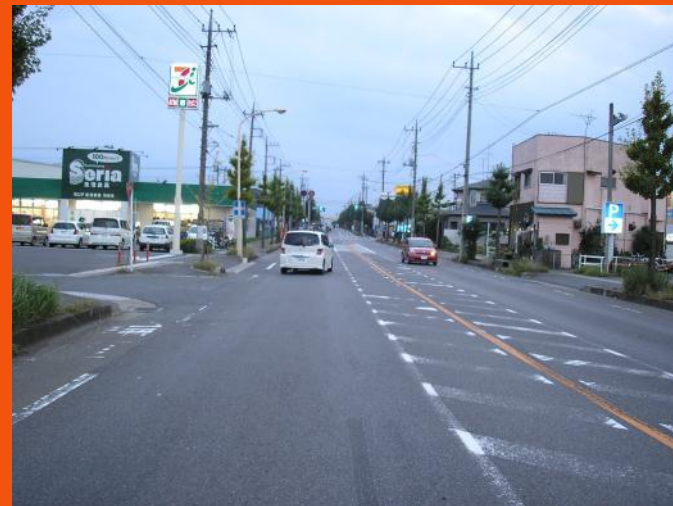
H22施工箇所
