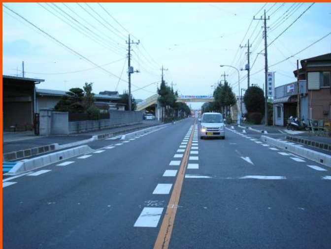
H21施工箇所
