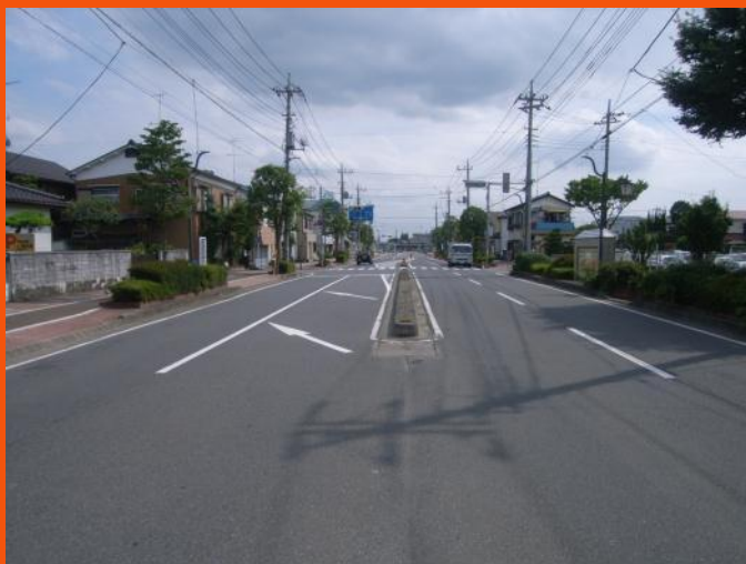
H21施工済箇所
