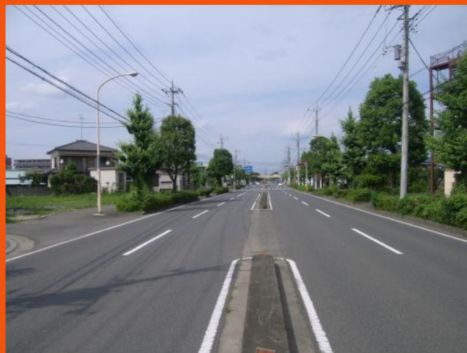
H22施工箇所
