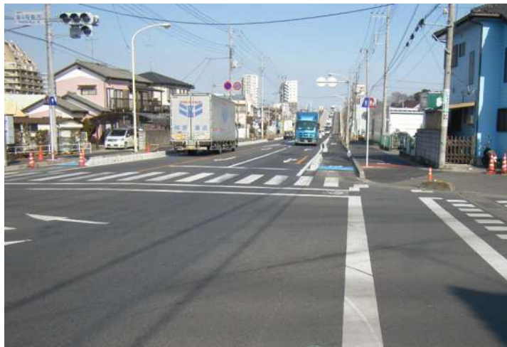
◆ H22施工済箇所
