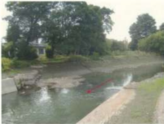
護岸工(安養寺堰上流) 整備前
