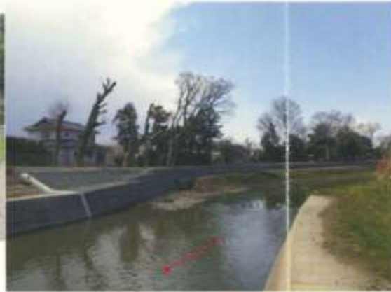
護岸工(安養寺堰上流) 整備後
