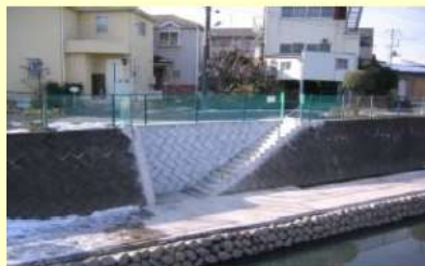
階段通路整備
