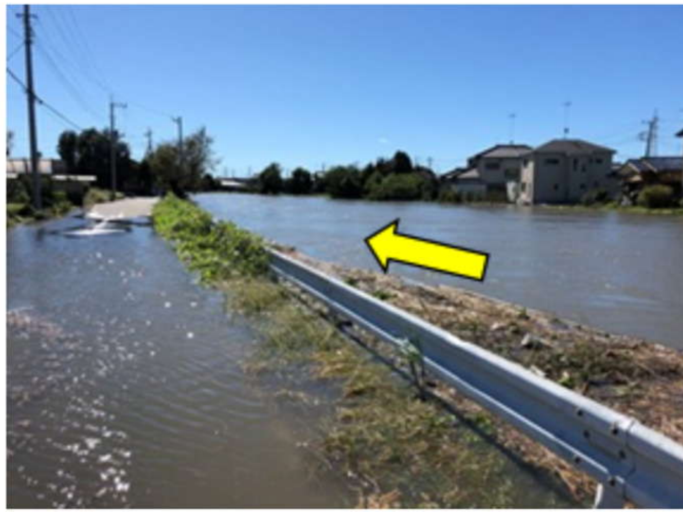
10/13三谷橋（左岸：下流側）
