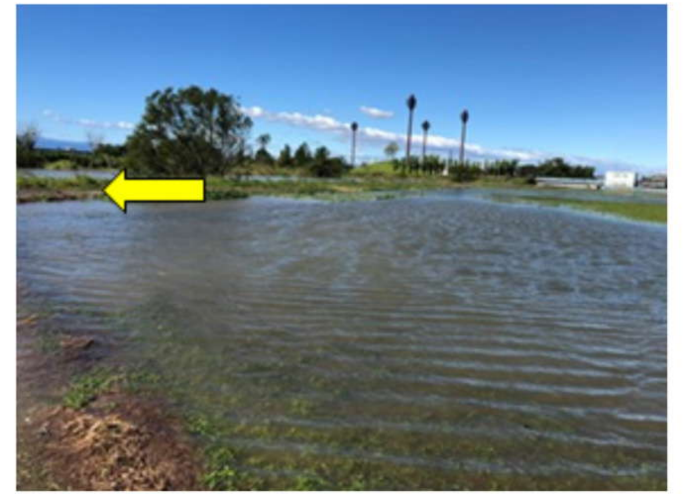
10/13中斉橋（右岸：下流側）
