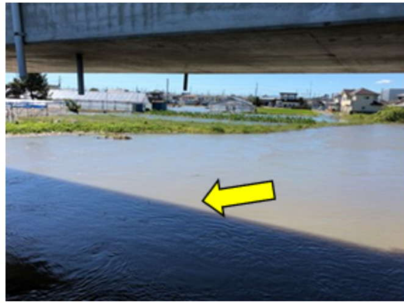
10/13郷地橋上流側市道橋（右岸：上流側）
