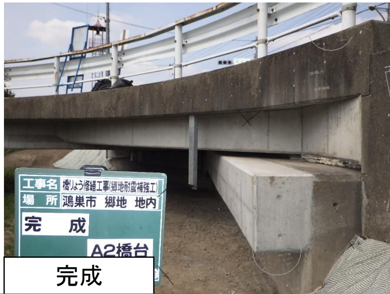
郷地橋 耐震補強工事
