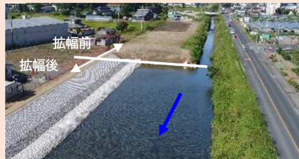
洪水時の水位を低下させるため河道を拡幅
