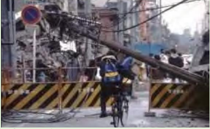
阪神淡路大震災の際の電柱倒壊
