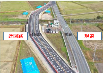
橋りょう架換え工事鴻巣川島線(寺家谷橋)
