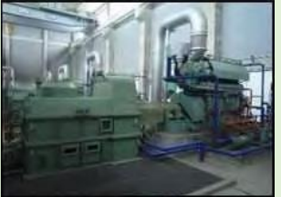
排水機場のポンプの更新等
