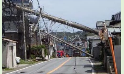
令和元年房総半島台風による電柱倒壊
