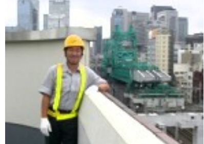
東北縦貫線 工事の現況(神田駅周辺)
