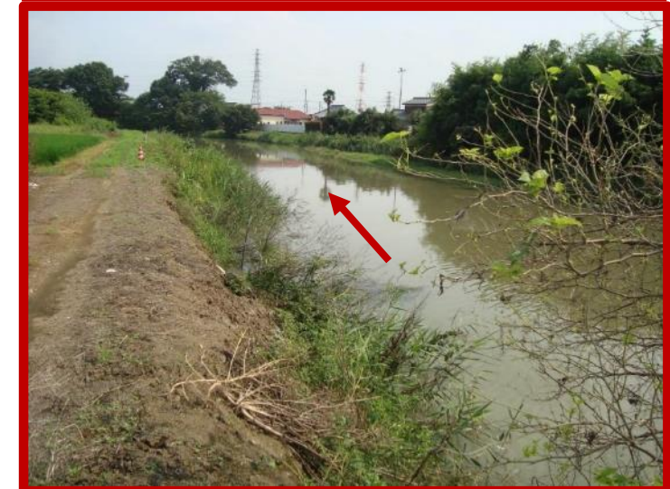
平成30年度予定区間 (L=300m) 左岸側より
