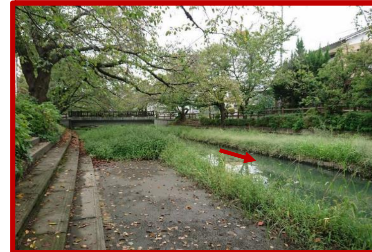
平成30年度予定区間 (L=80m) 右岸側より
