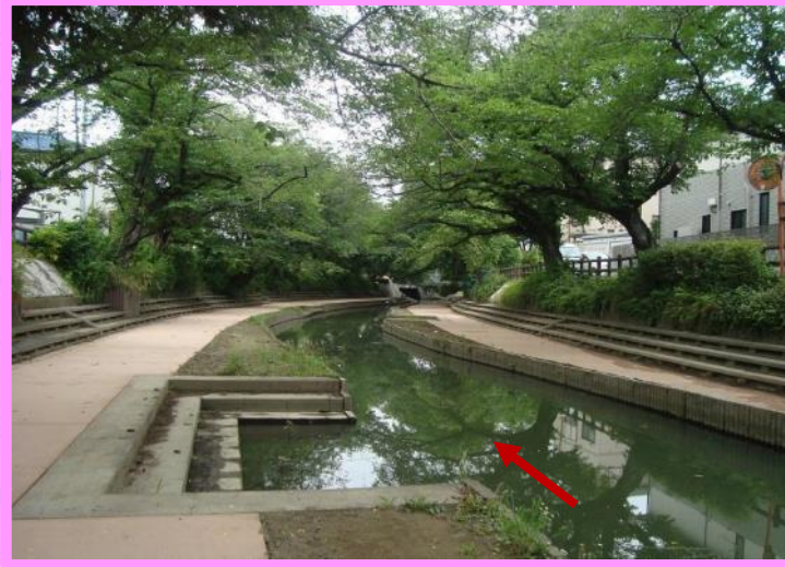
平成29年度完成区間（散策路）左岸側より
