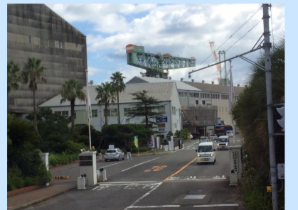
ジャイアント・カンチレバークレーン
