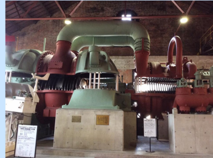
関西電力尼崎第一発電所1号タービン
