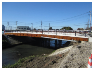
笠原大橋 上部工その1
