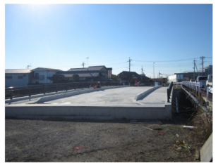
笠原大橋 上部工その2
